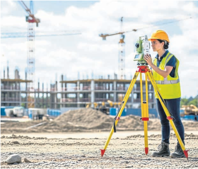
Vermessungstechnikerinnen und Vermessungstechniker erfassen auf Baustellen mit modernen Messgeräten präzise Geländedaten, die anschließend digital zu Plänen und Modellen weiterverarbeitet werden. Foto: Dmitry - stock.adobe.com
