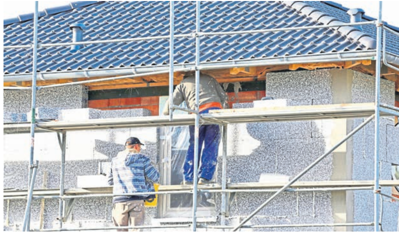
Millimetergenaue Montage in mehreren Metern Höhe: Jede Platte muss sitzen, damit Dämmung und Fassade dauerhaft schützen. Foto: Kara - stock.adobe.com
